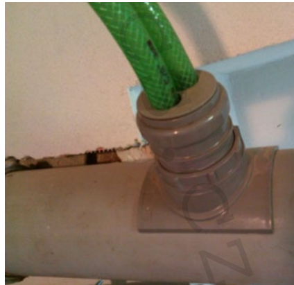
Zapojení dvou odpadů do kanalizace:
